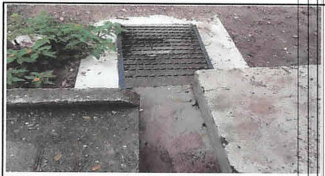
Foto 4: Destrucción de la tubería de captacion de aguas fluviales
